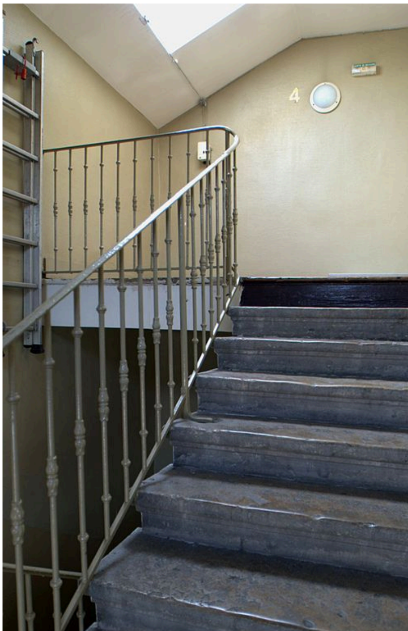
Palier de l'étage sous comble
