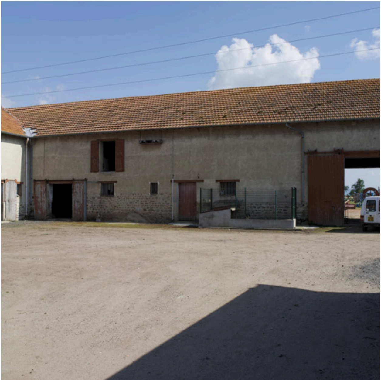
Vue d'ensemble intérieure de la cour, depuis le nord : grange-étable.
