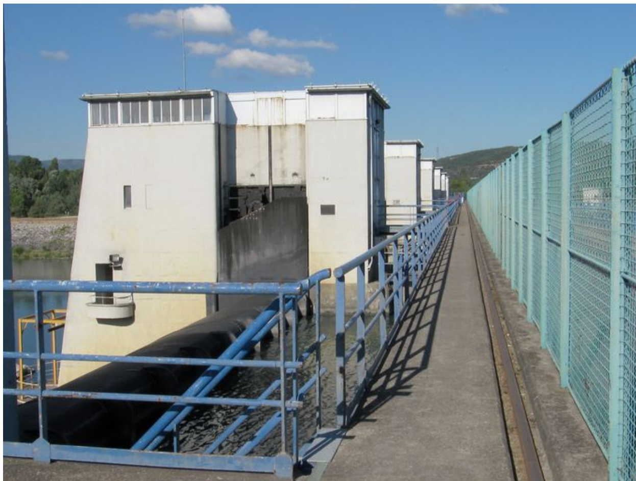
Passerelle (depuis la rive gauche)
