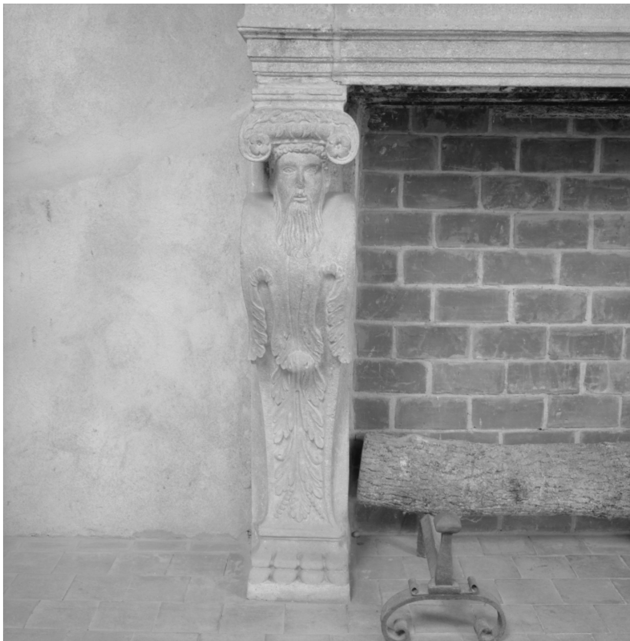
Piédroit gauche d'une cheminée du rez-de-chaussée du bastion est.
