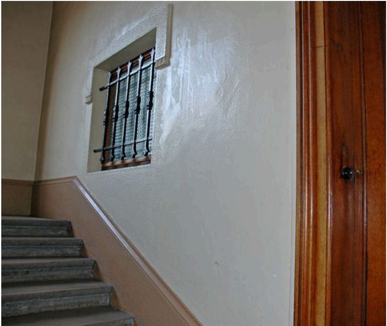
Baie d'appartement ouvrant sur la montée d'escalier
