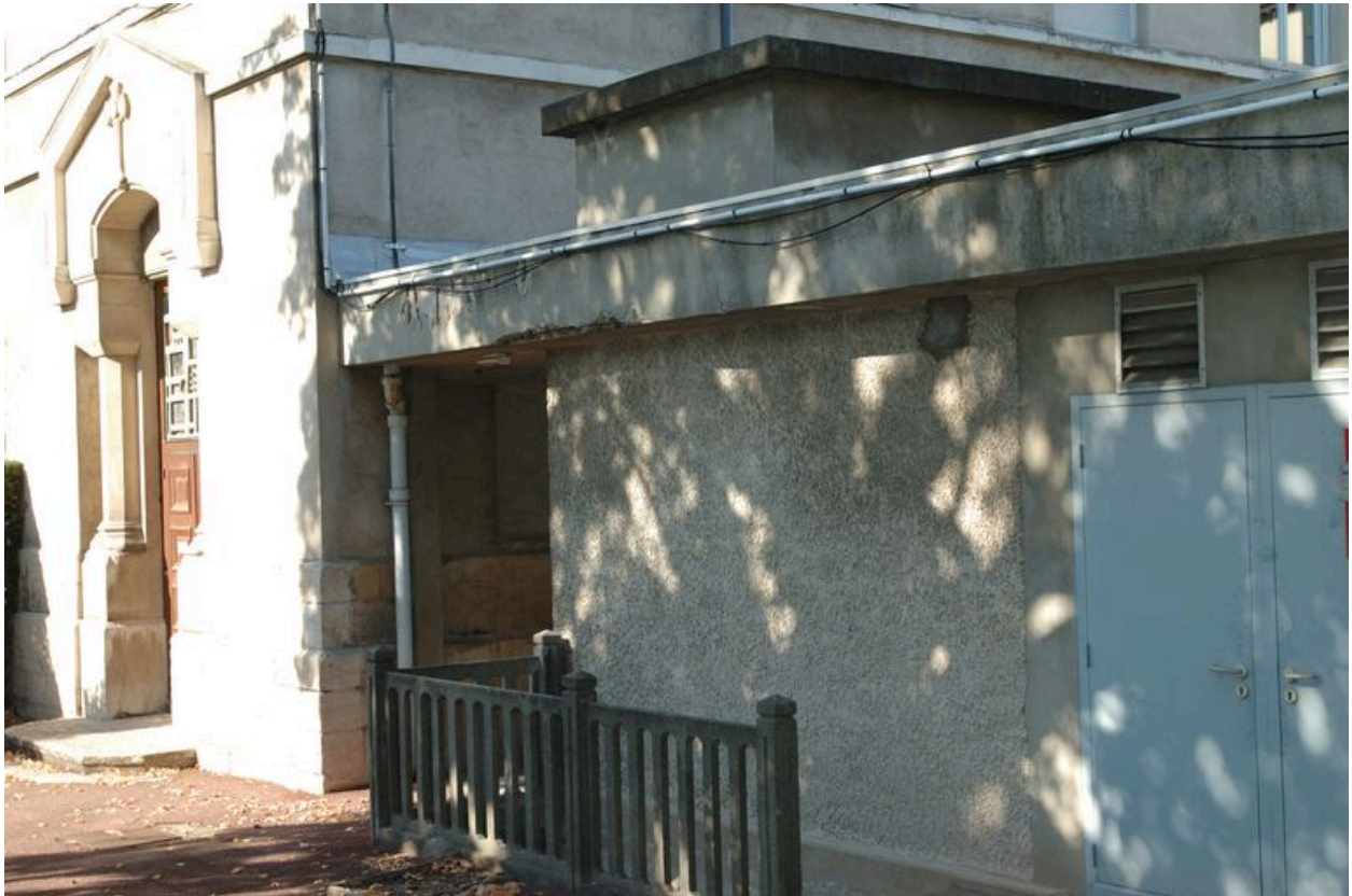
Détail de l'entrée de la chapelle et de la morgue.
