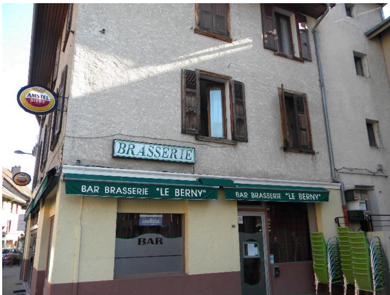
Façade sud d'un immeuble Place Sadi Carnot (2008 D15 2446).
