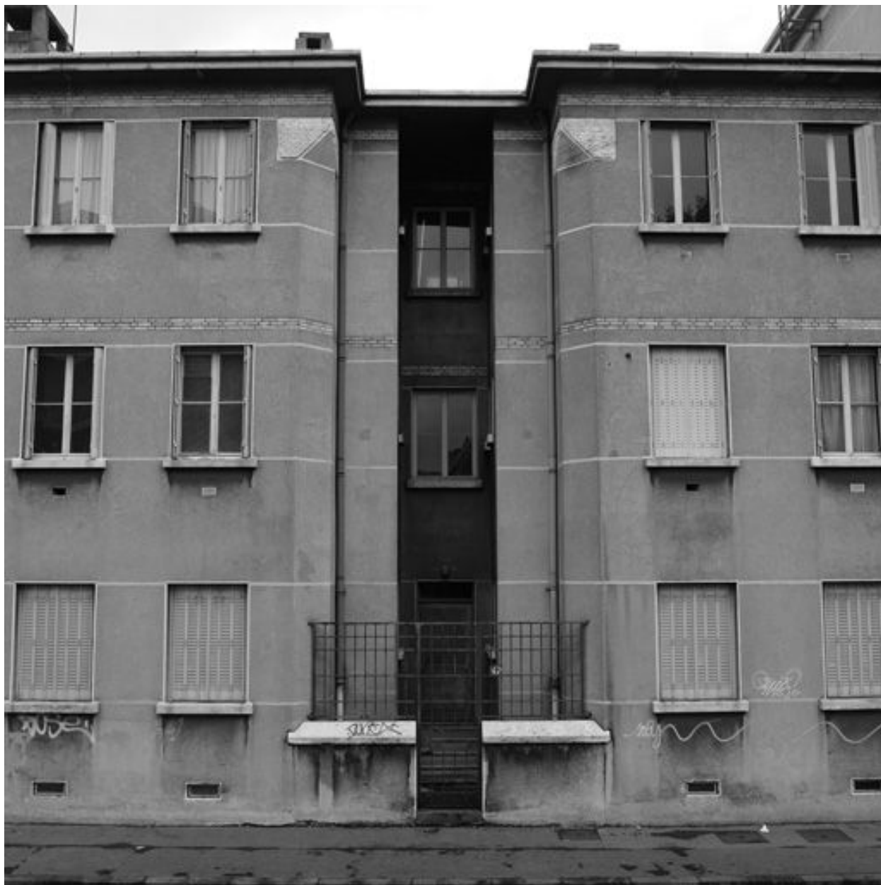
Elévation ouest de l'aumonerie (bâtiment 12) sur la rue du Professeur-Florence
