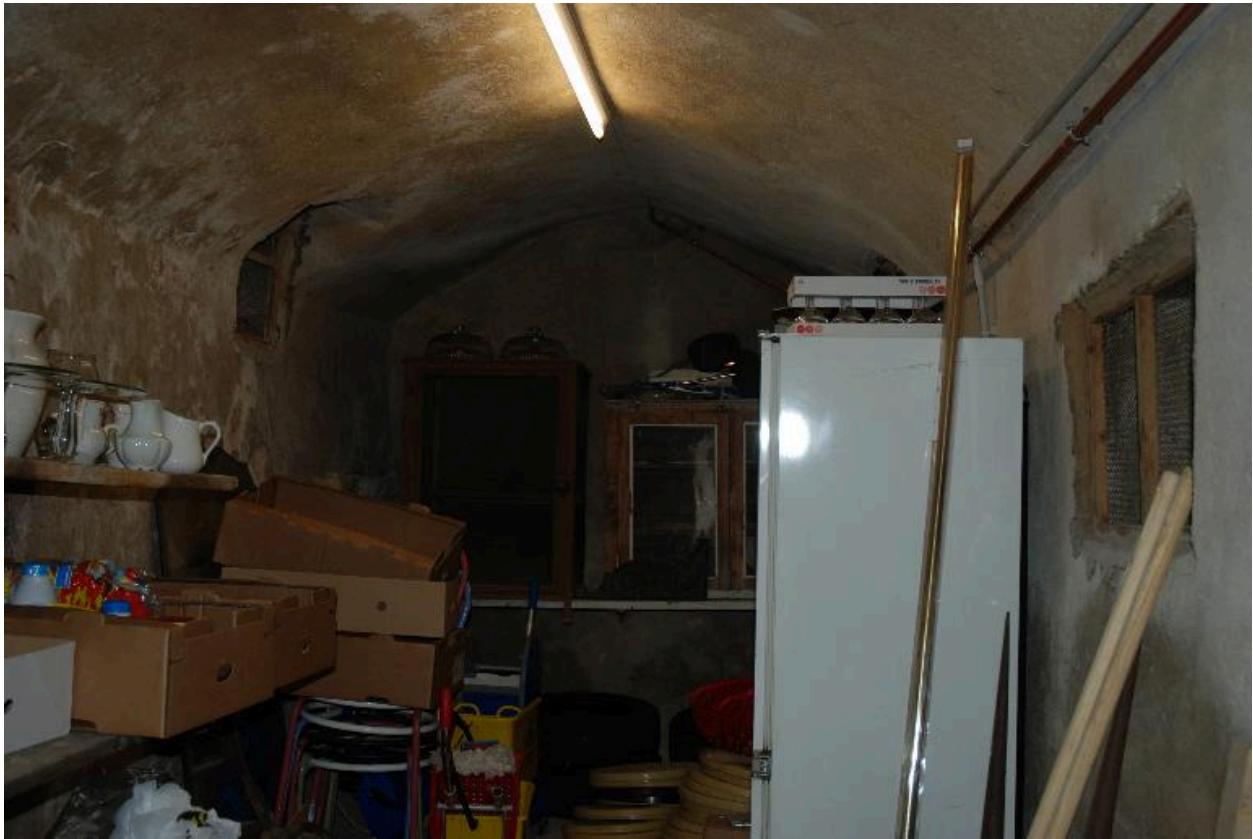
Rez-de-chaussée. Intérieur de la cave 2, vue d'ensemble.
