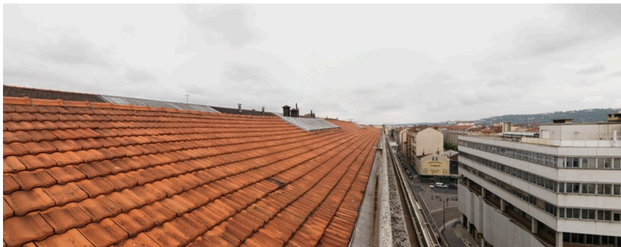
Vue nord des toits (côté rue de Marseille)
