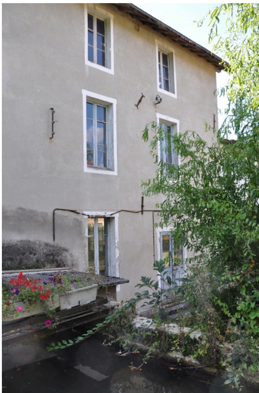
Vue de la façade nord avec le canal d'amenée
