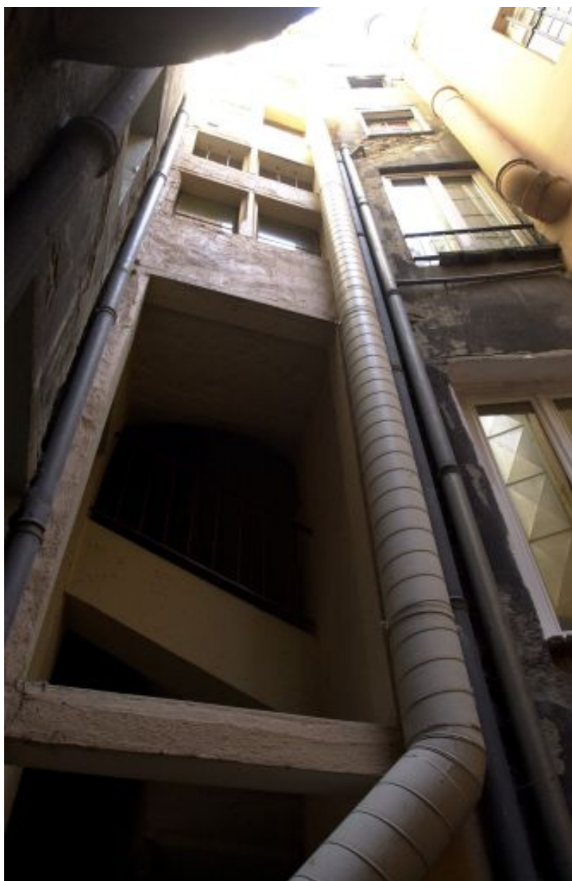
Façade sur cour de l'escalier, partie supérieure
