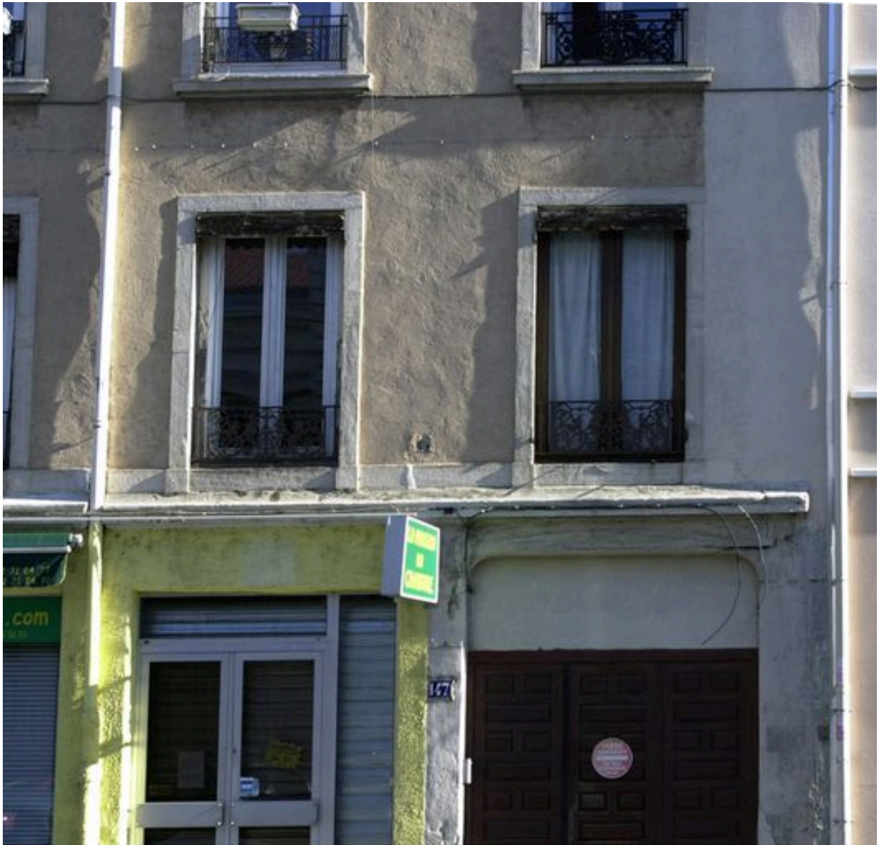
Élévation antérieure, détail des fenêtres
