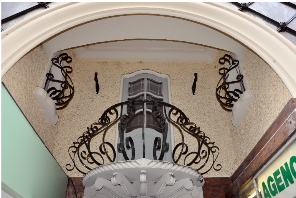
Corps principal : balcon de l'entresol dans le porche sud, rue du Casino
