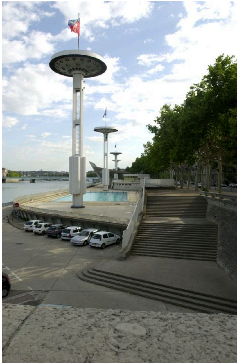
Vue depuis le sud : l'escalier d'accès au quai
