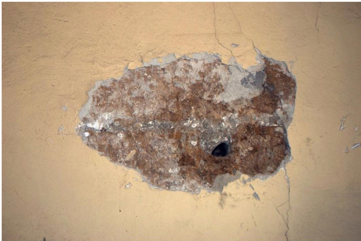
Immeuble sur rue : détail du mur de la cage d'escalier, révélant le pisé sous l'enduit
