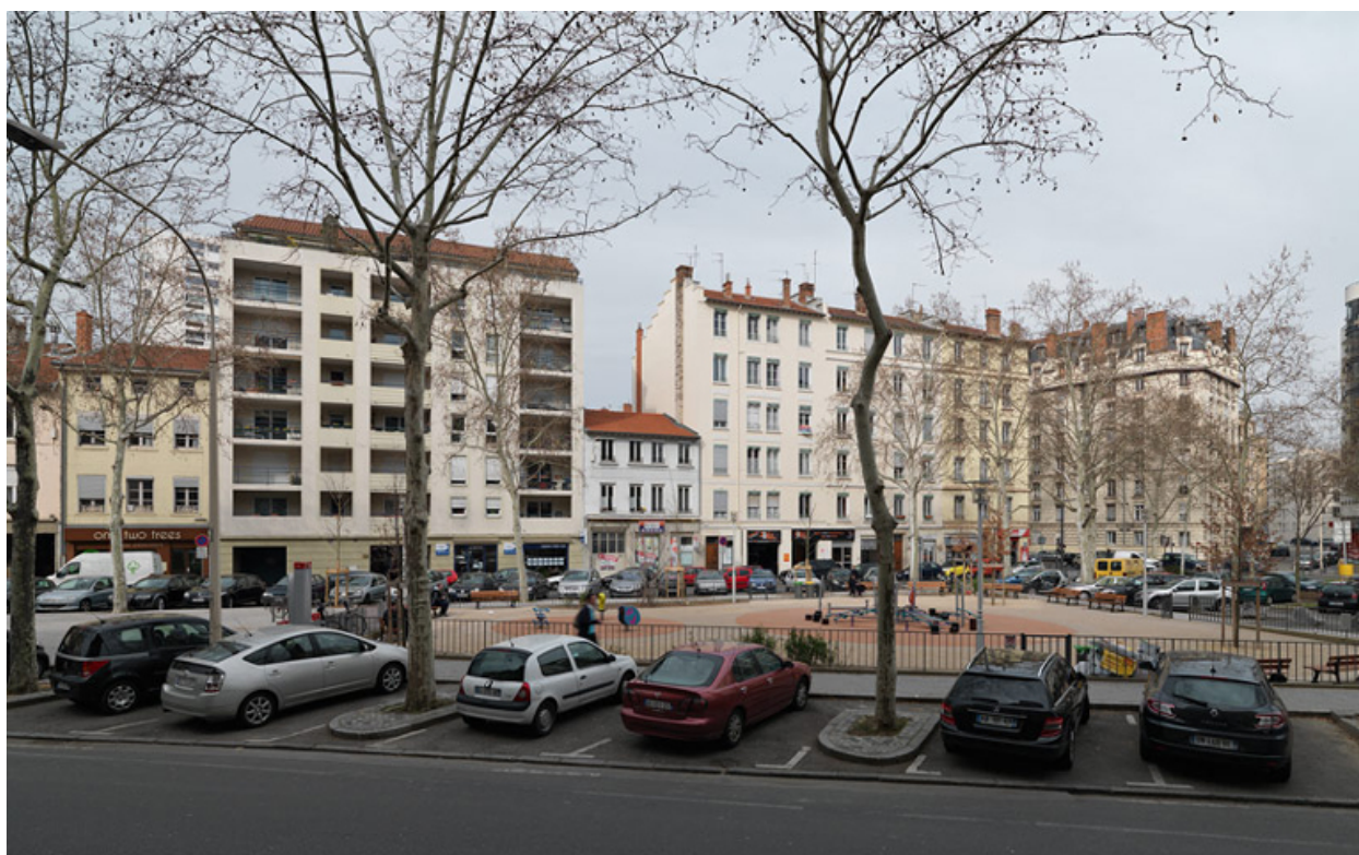
Alignement des façades de la Grande rue de la Guillotière et de la rue Abbé-Boisard (est)
