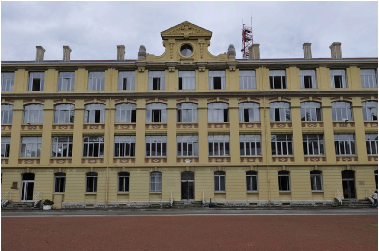
Bâtiment daté de 1916. Façade nord.
