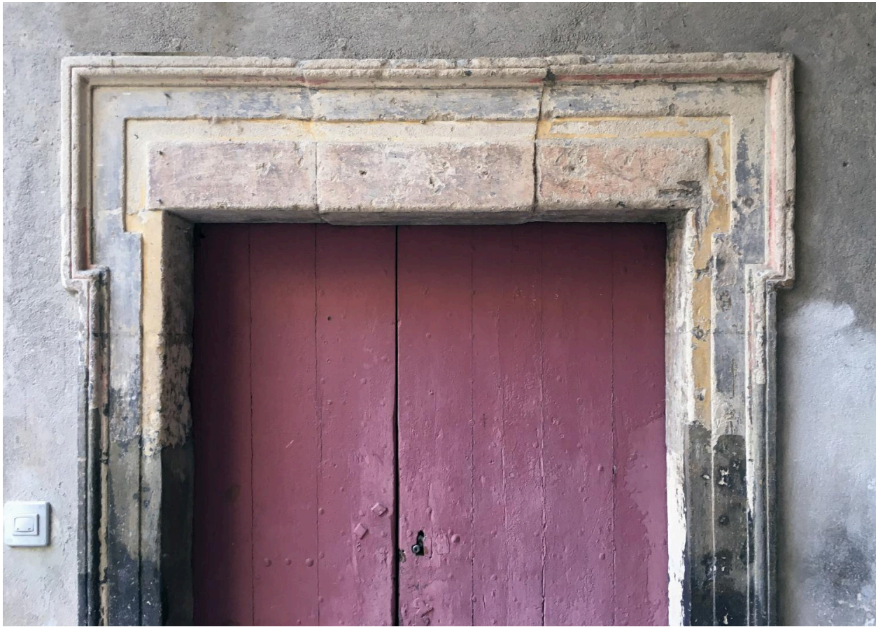
Bâtiment A, galerie nord : détail de l'encadrement de la porte ouest : traces de polychromie sur la pierre
