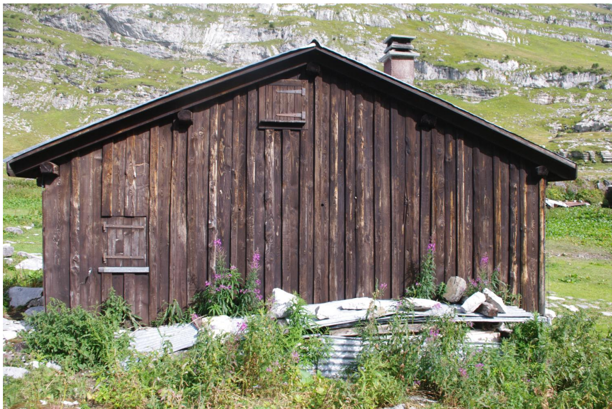
Vue du mur pignon ouest
