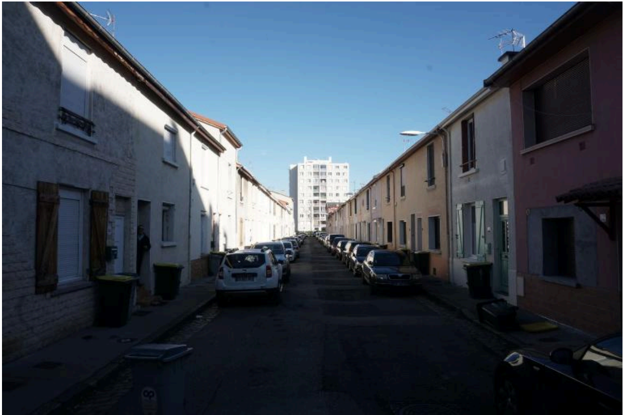
Vue générale sud rue Brachet
