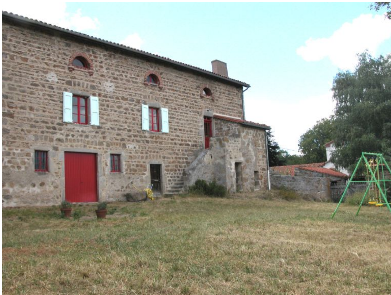
Vue d'ensemble de la façade sud de la ferme.
