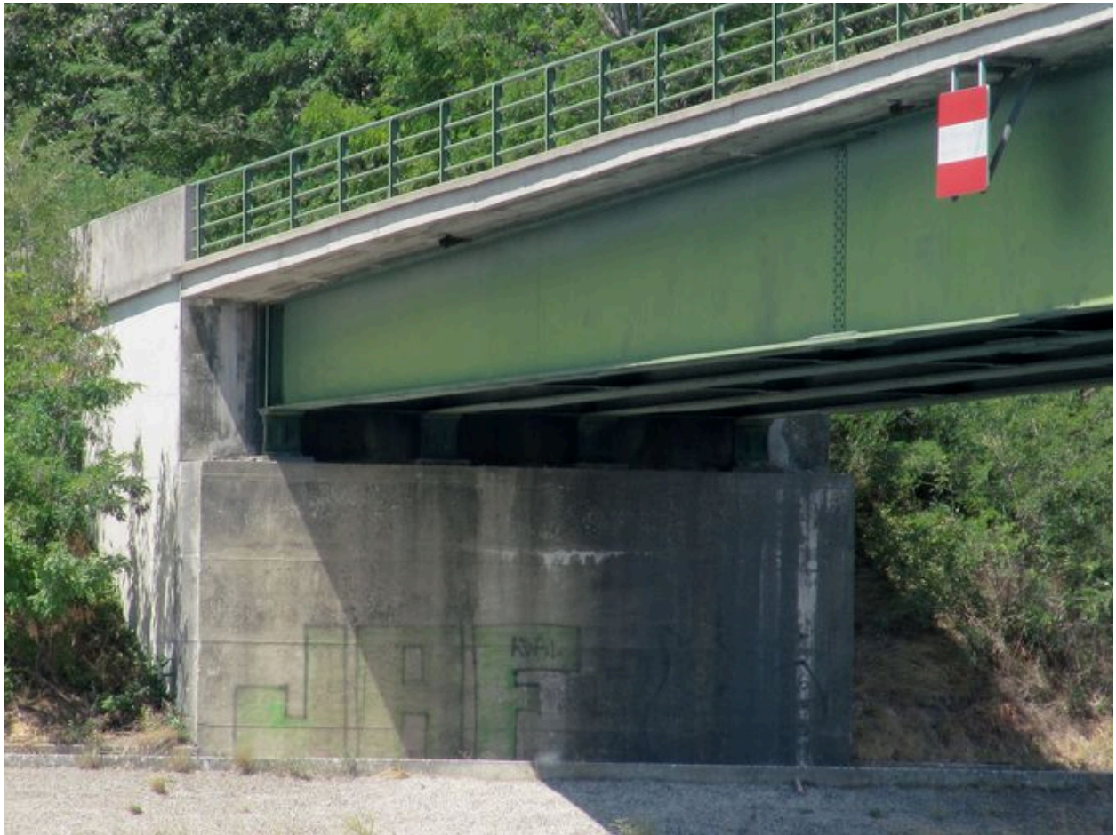
Culée droite, de côté, face aval, vue partielle : jonction avec le tablier (depuis la rive gauche)
