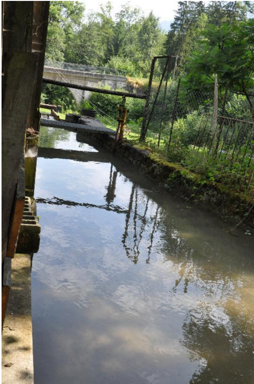
Vue d'une partie du canal d'amenée.
