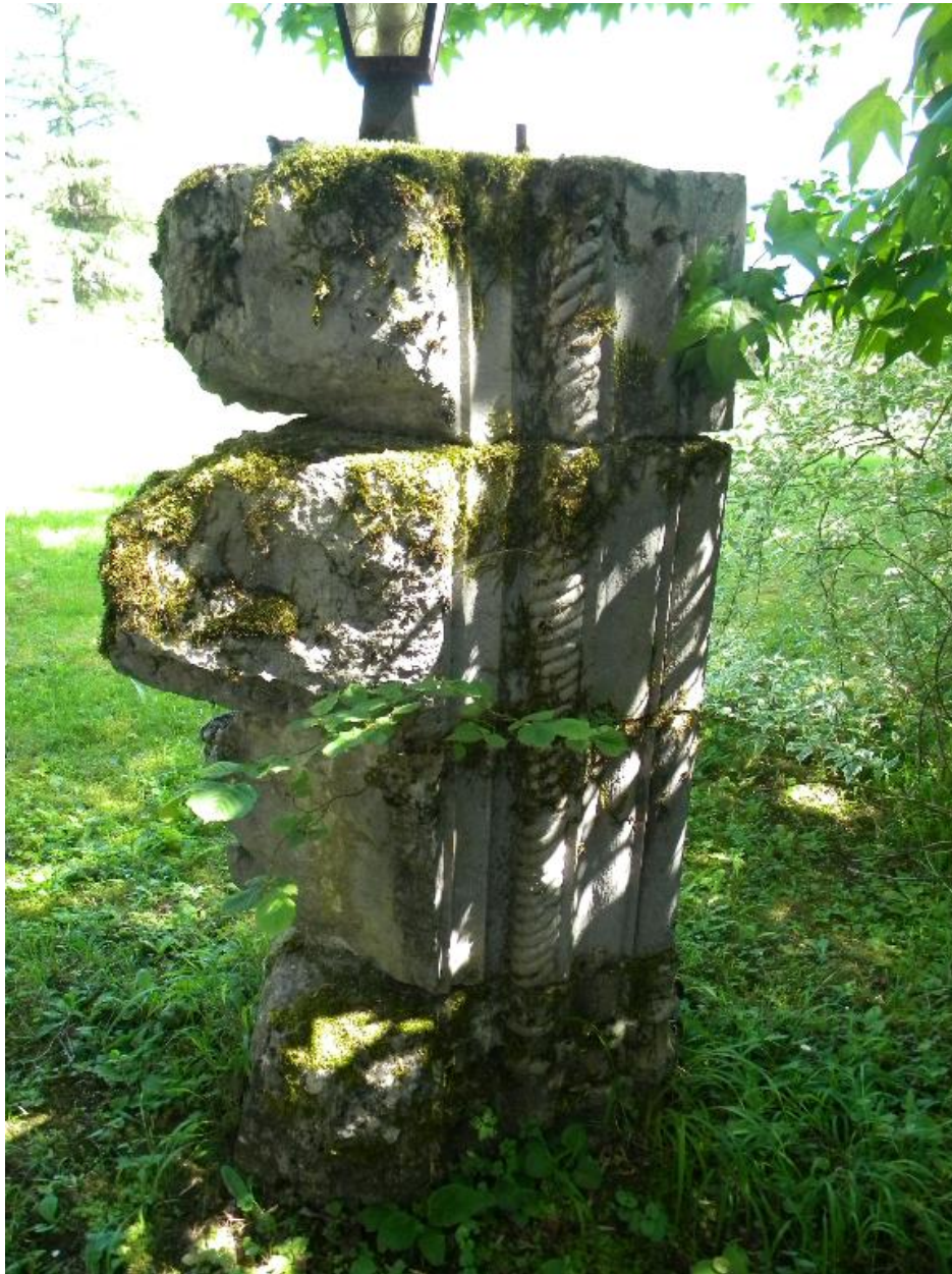
Vue d'un vestige de piédroit.
