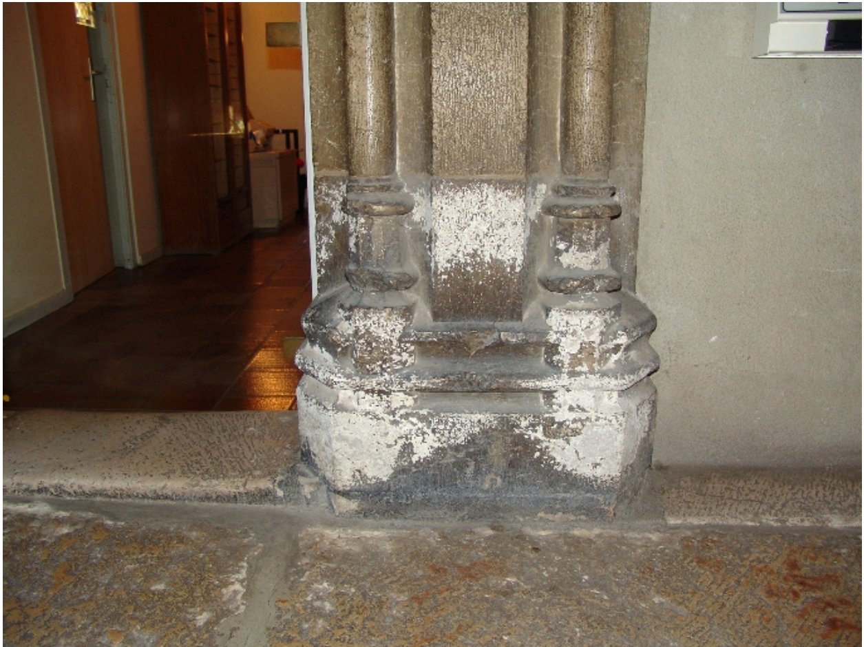
Porte du rez-de-chaussée, détail de bases de colonnettes
