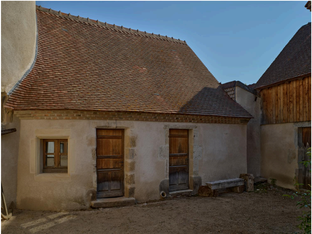
Vue de détail de la façade méridionale côté cour après restauration.
