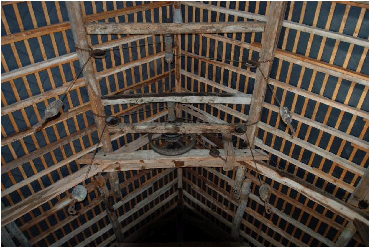
Vue partielle de la charpente avec mécanisme d'élévation des chars à foin.
