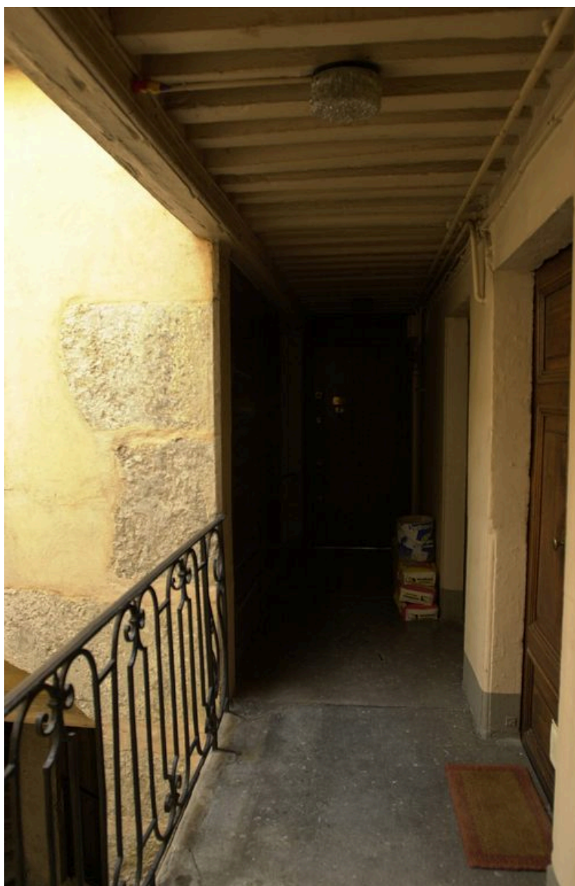
Galerie du dernier étage et porte palière
