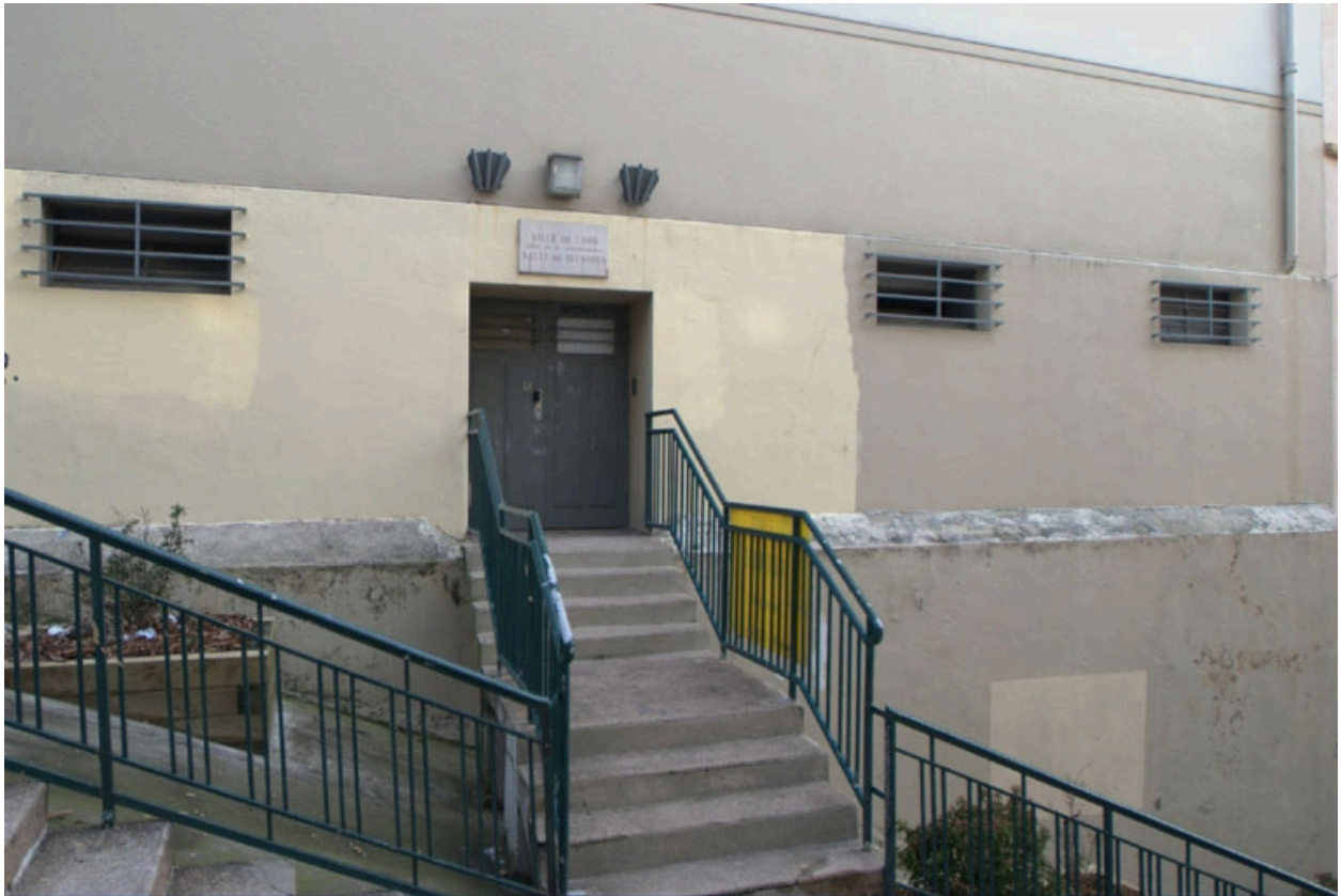
Entrée latérale ouest du bâtiment municipal
