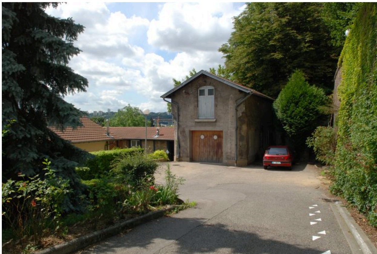
Vue du bâtiment à usage actuel de garage, devant être détruit.
