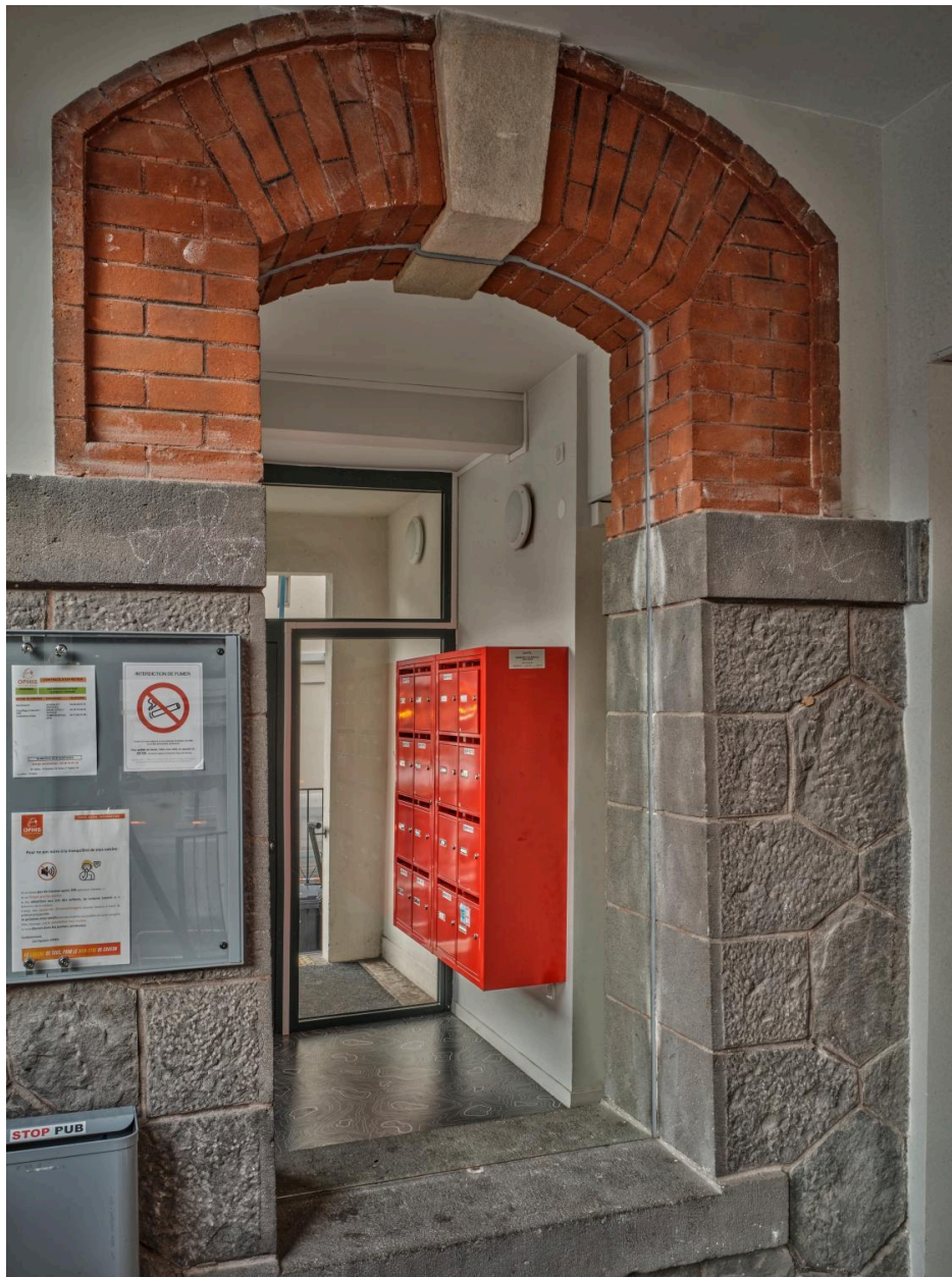
Baie à l'intérieur du hall d'entrée
