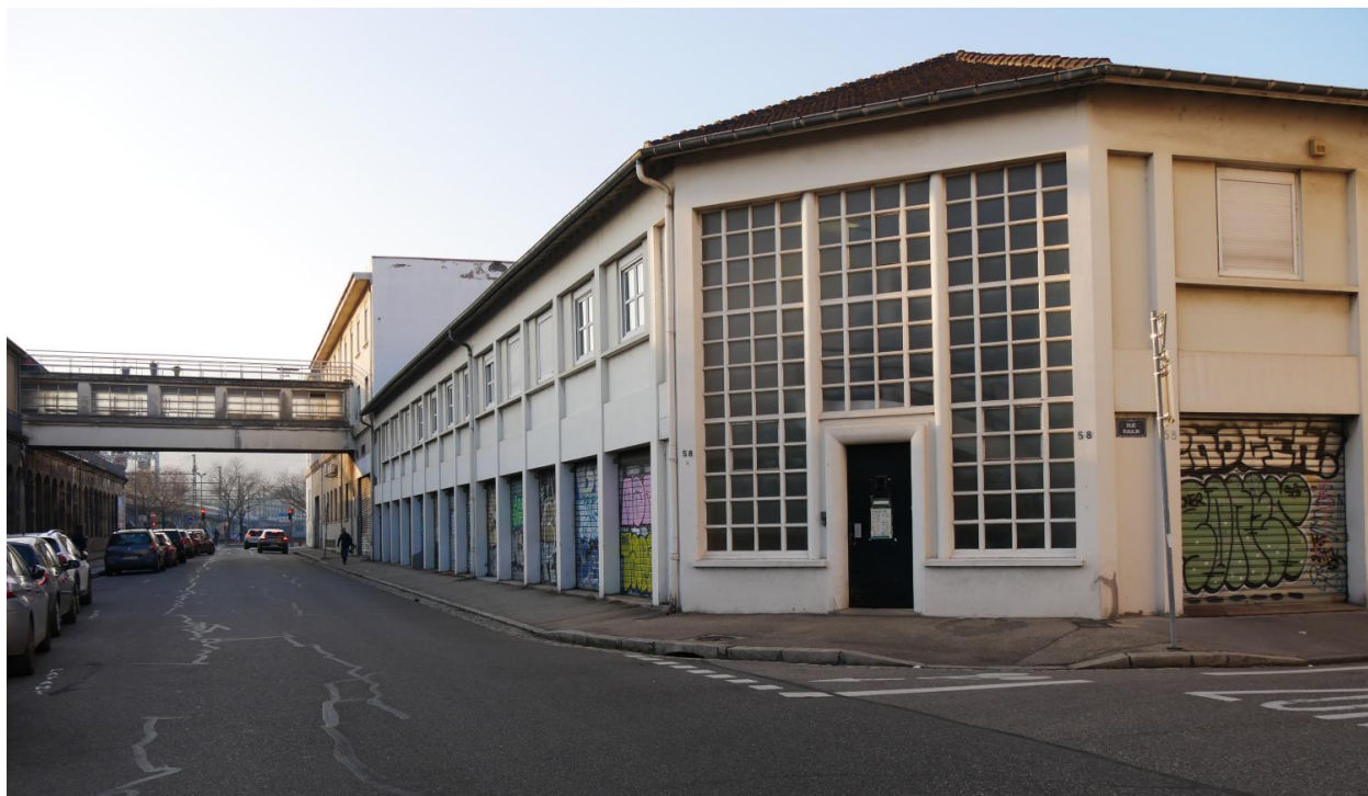
Vue d'ensemble nord-est
