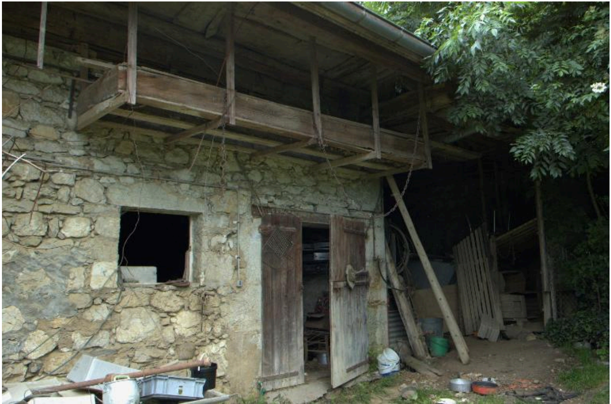
Vue partielle de la façade principale, partie est.
