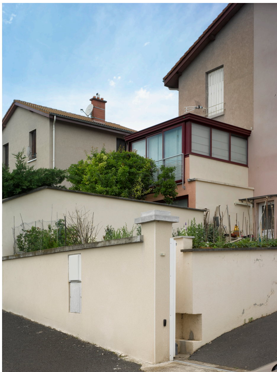
Détail des transformations d'une maison ouvrière, allée des Côtes-de-Chanturgue (partie sud-est de la cité, n° 23).
