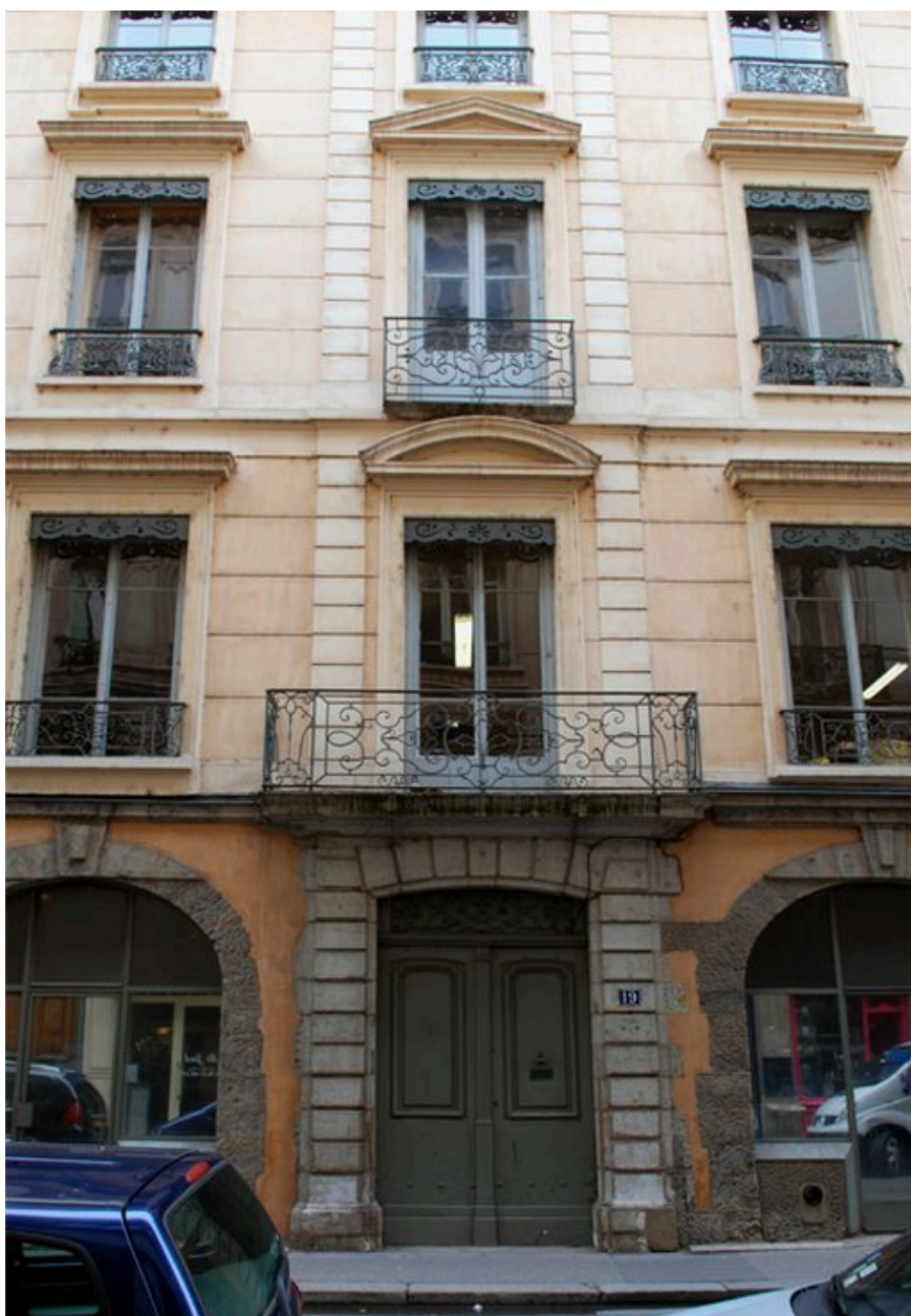
Elévation antérieure, travée centrale
