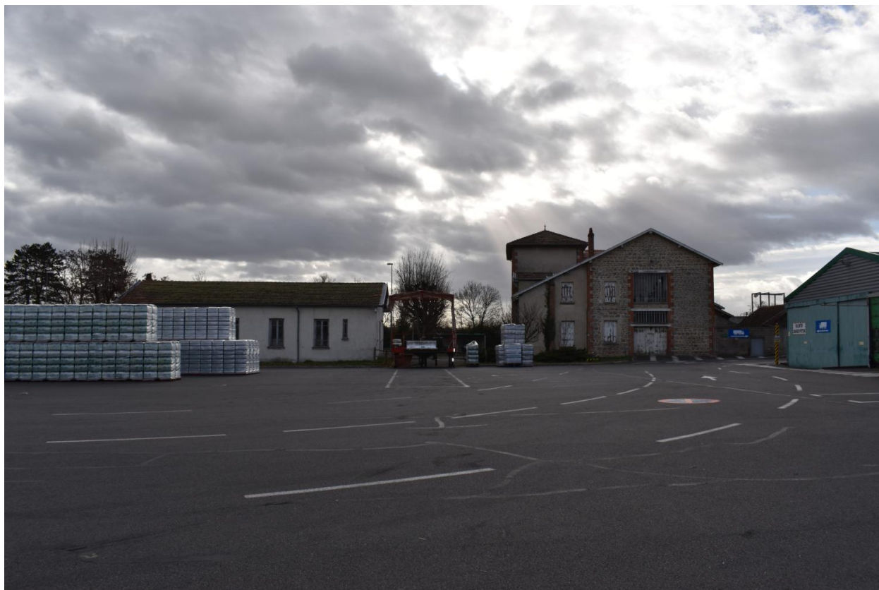
Vue d'ensemble des bâtiments d'origine
