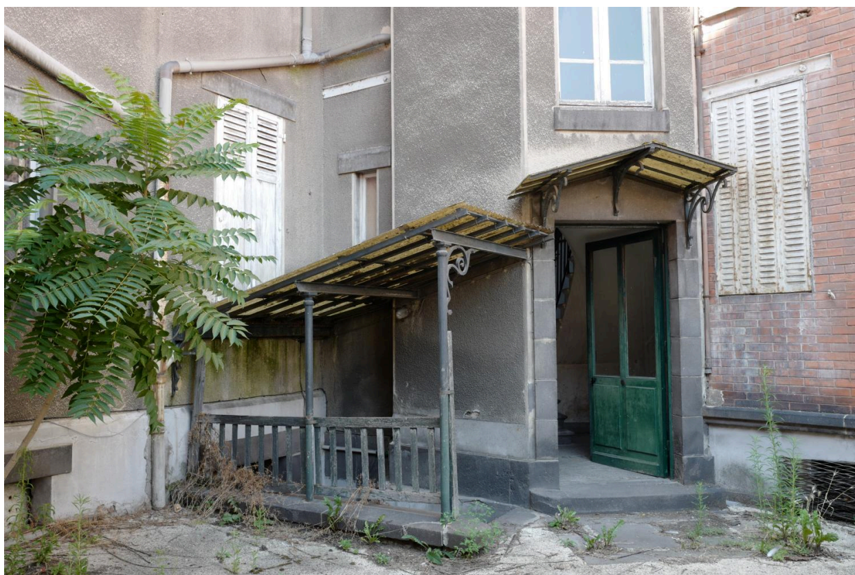
Porte d'entrée de la tour d'escalier et accès à la cave
