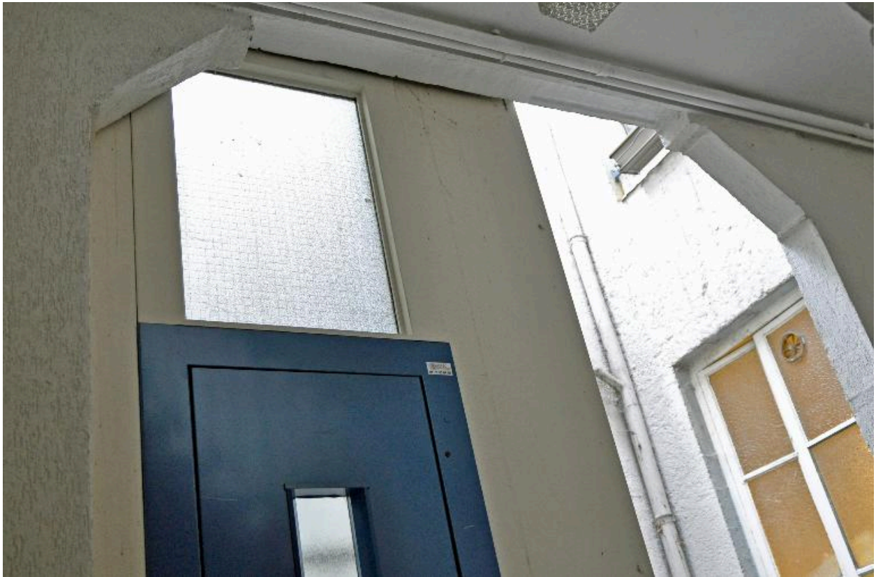
Cage d'escalier ouverte sur la cour, détail des consoles supportant les paliers
