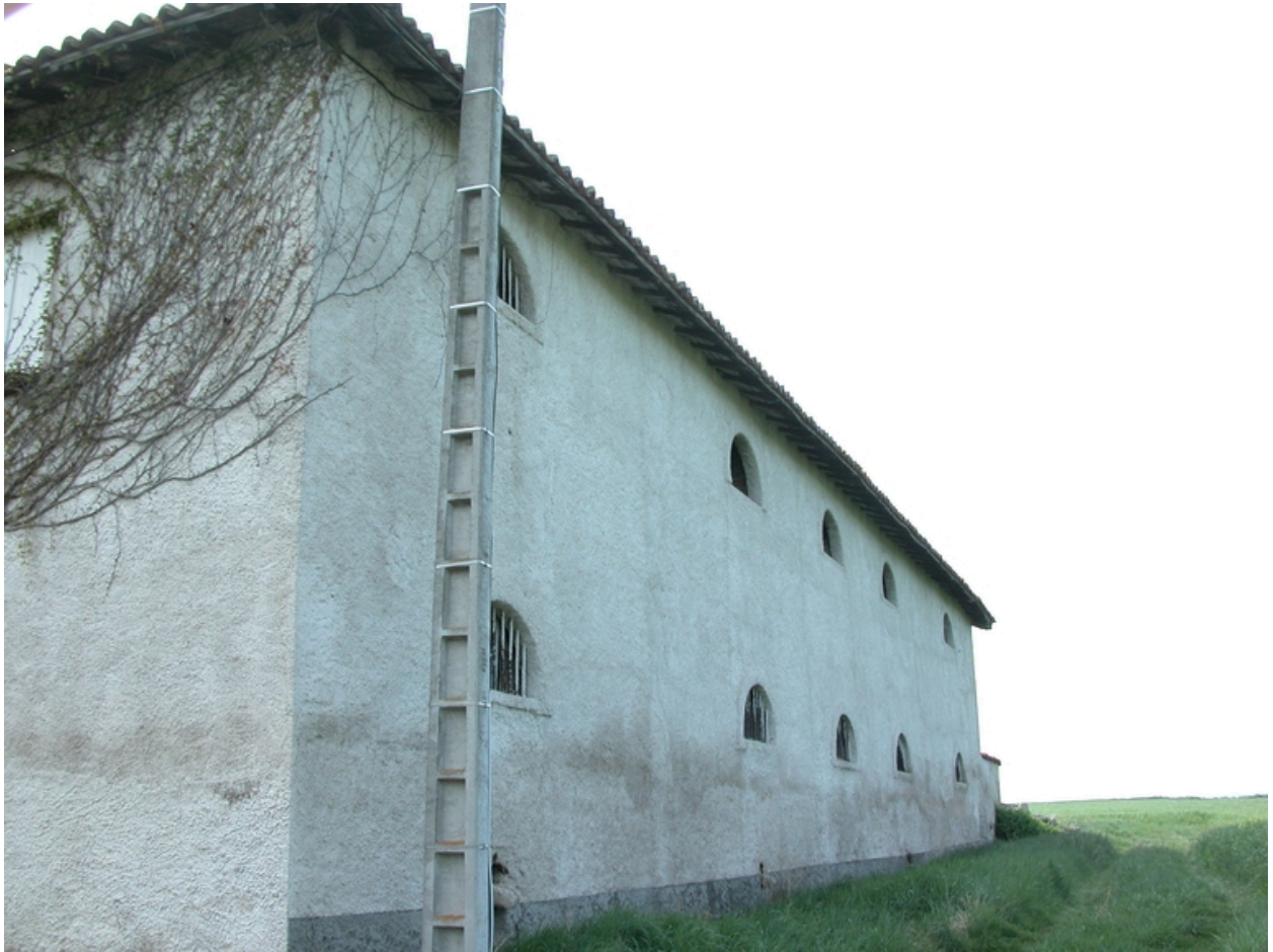
Vue de l'élévation postérieure du bâtiment ouest.
