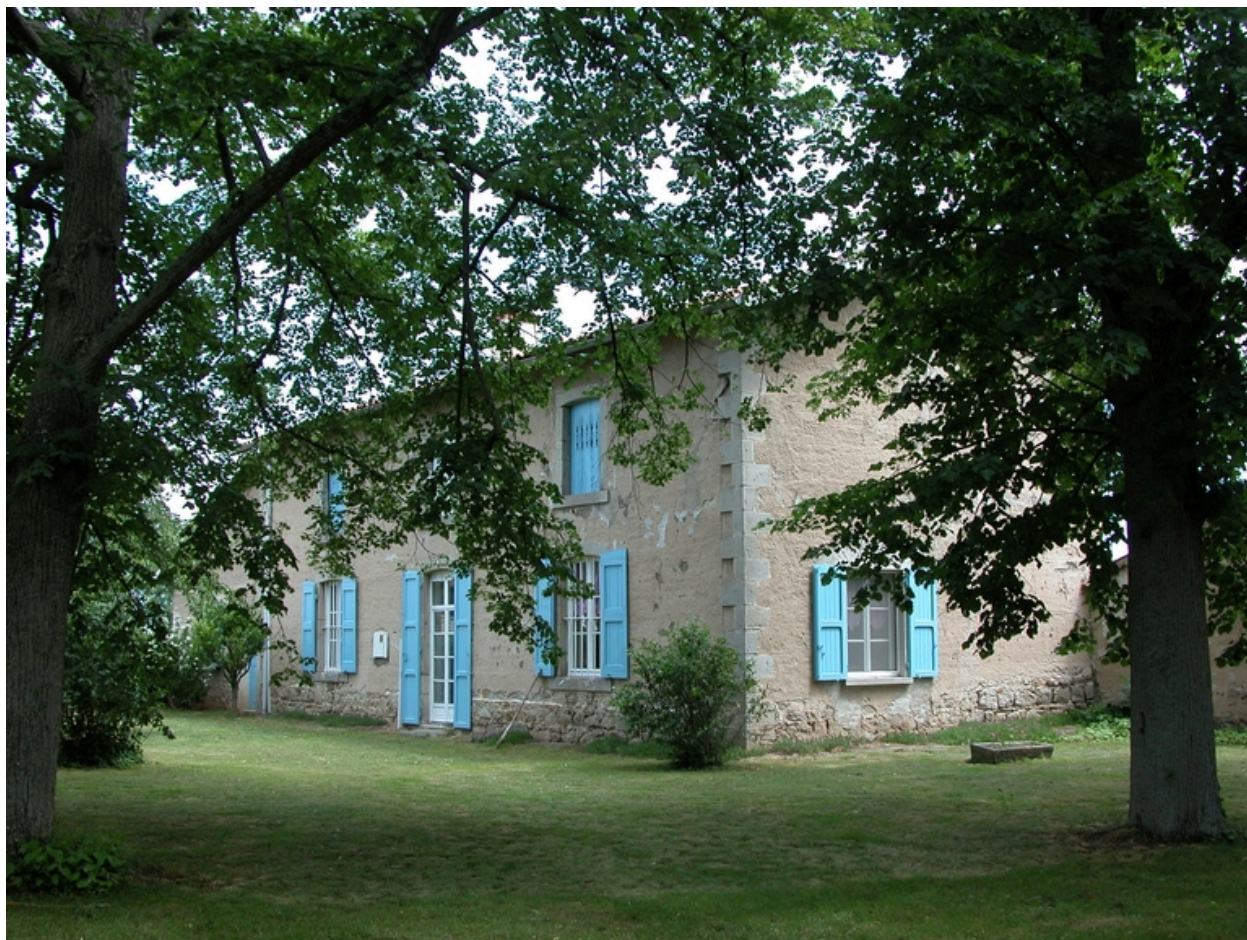
Vue d'ensemble du logis depuis le sud-ouest.
