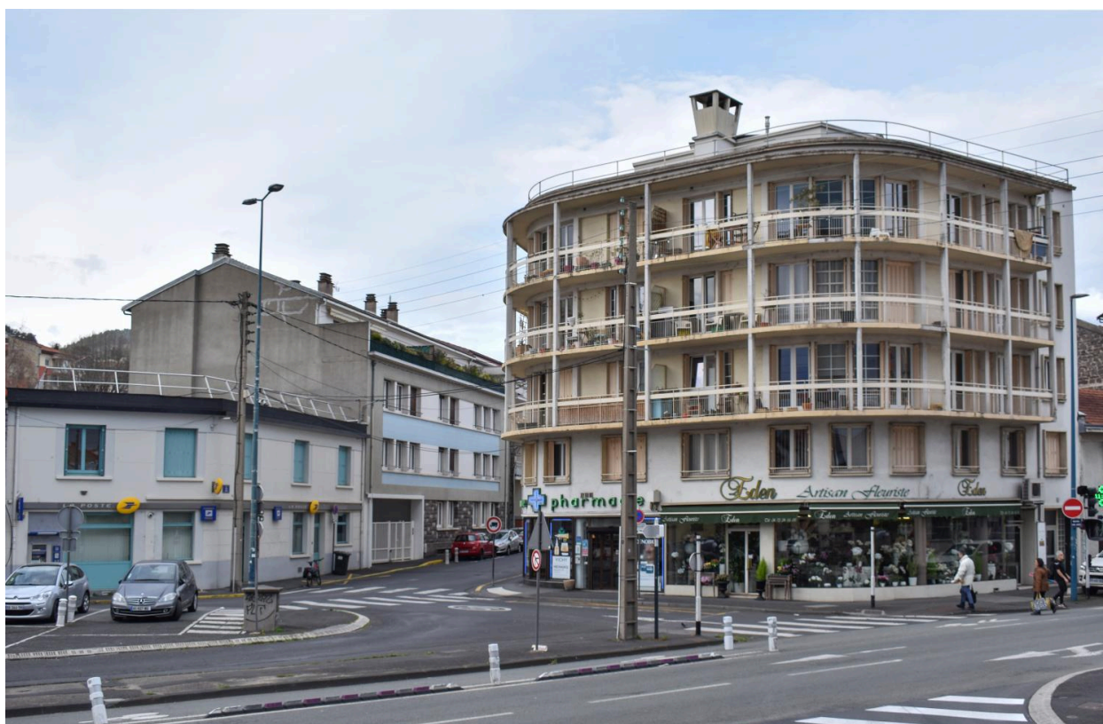
Façade sur la place Littré
