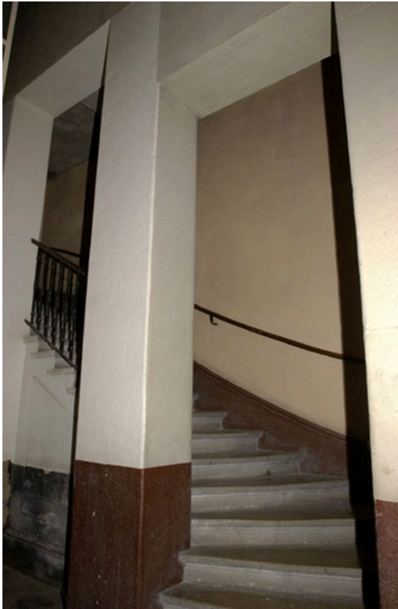
Vue du départ de l'escalier sur la droite du passage cocher
