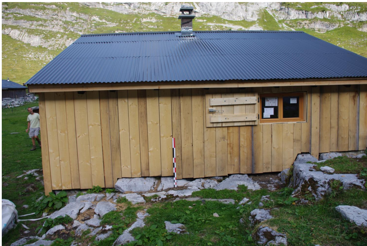
Vue de la façade postérieure ouest
