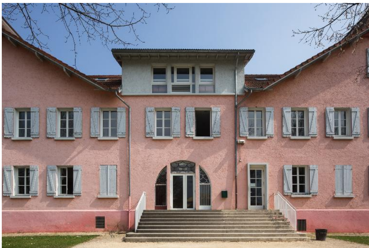
Bât. A : façade ouest de l'aile ouest. Détail de l'entrée
