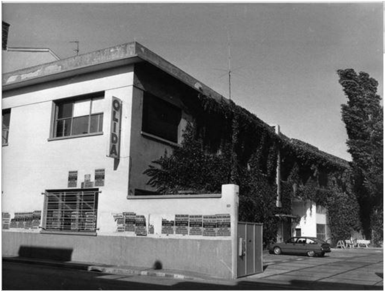
Vue du bâtiment administratif (BM Lyon)
