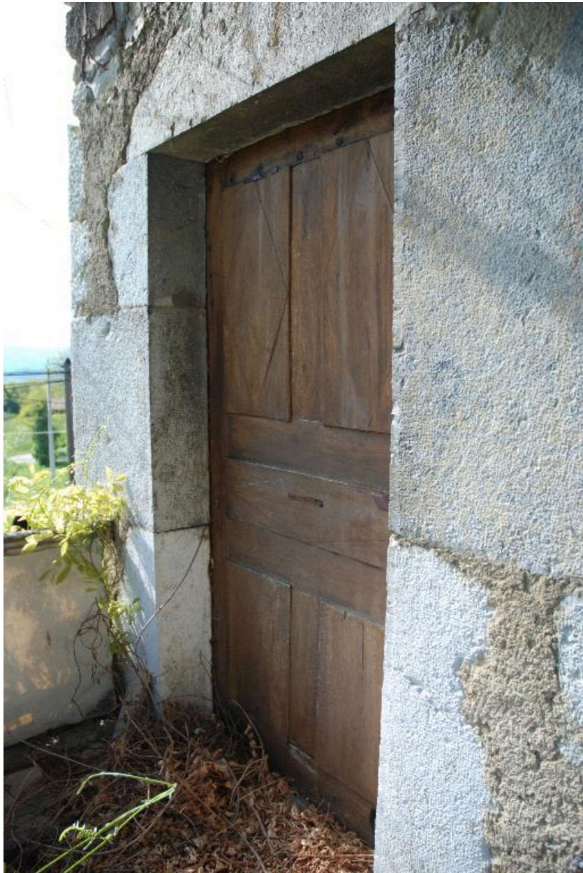
Détail de la porte du logis aval : angle du mur et piédroit de la fenêtre partagés.
