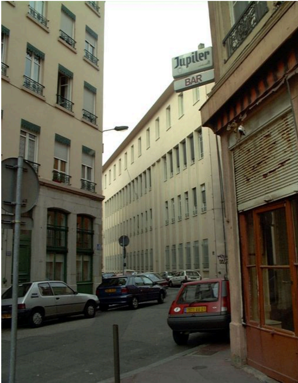
Vue de la façade rue Vaudrey
