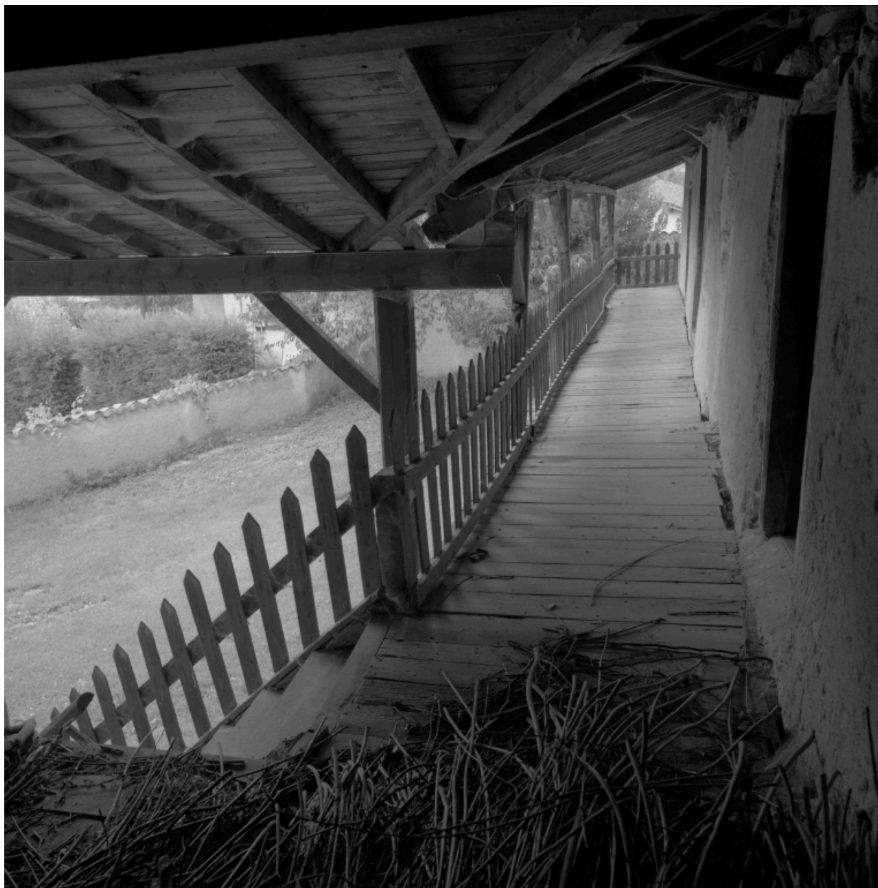
Vue de la galerie sur le logis ancien, depuis l'est.
