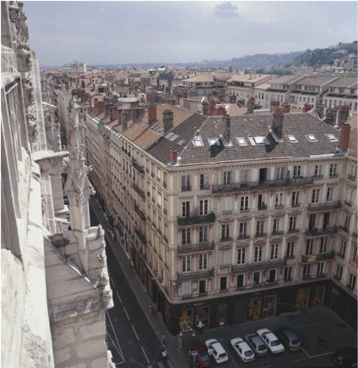
Vue générale depuis la tour nord de la collégiale Saint-Nizier
